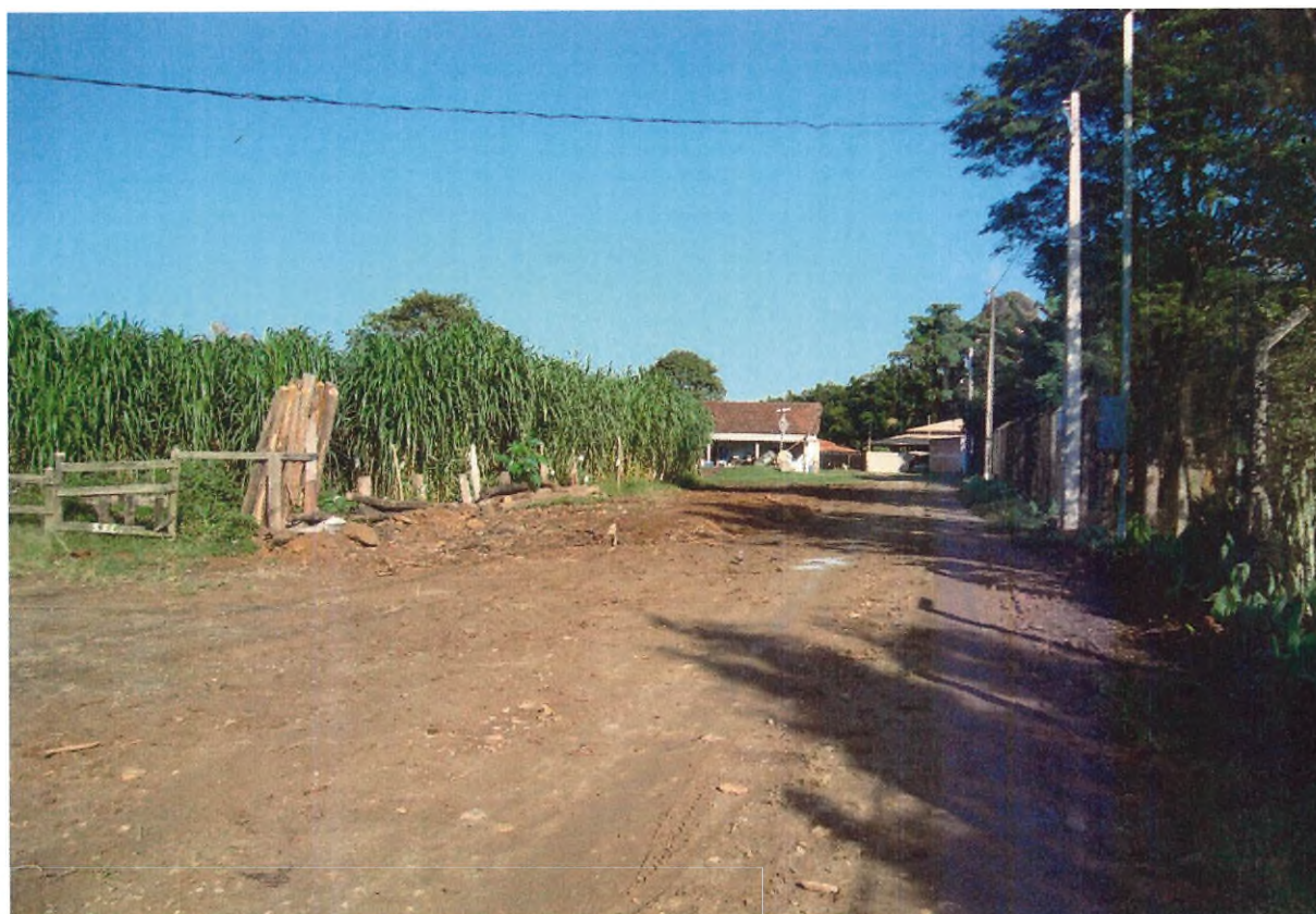
Foto 04: Trecho da Rua, onde foram retirados troncos de árvores que obstruíam parte da via.
