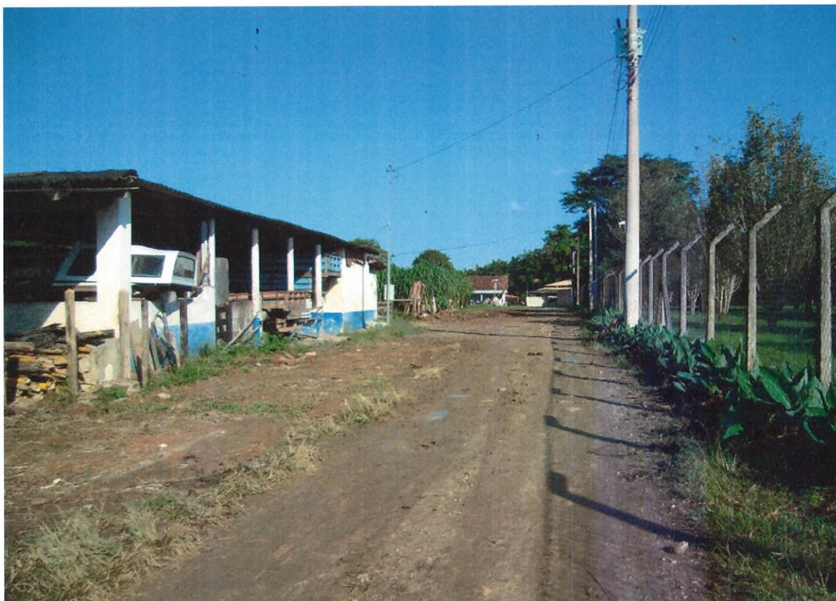
Foto 03: Início da Rua Projetada, onde existem dois postes de transmissão de energia, porém sem nenhuma iluminação pública.
