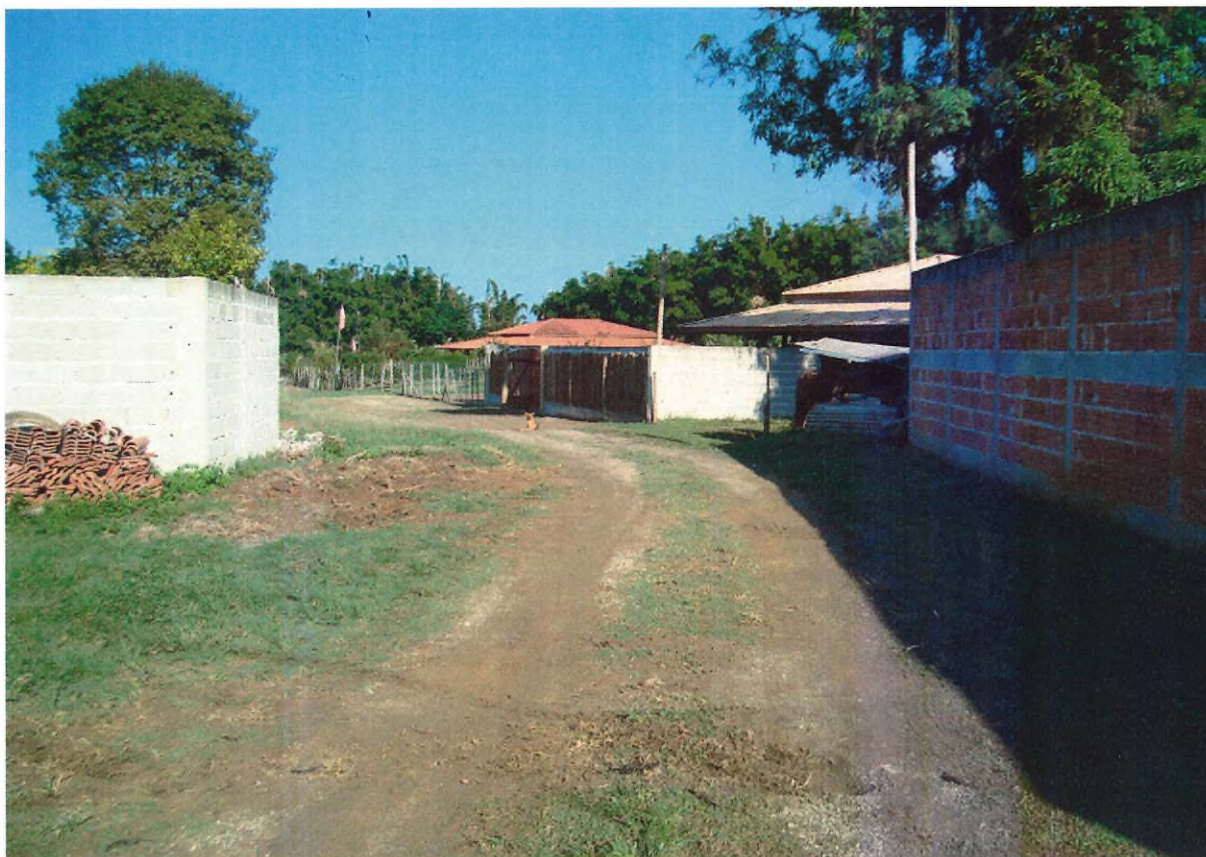
Foto 05: Atualmente a Rua possui 9,00 m de largura, ao longo de toda a sua extensão.
