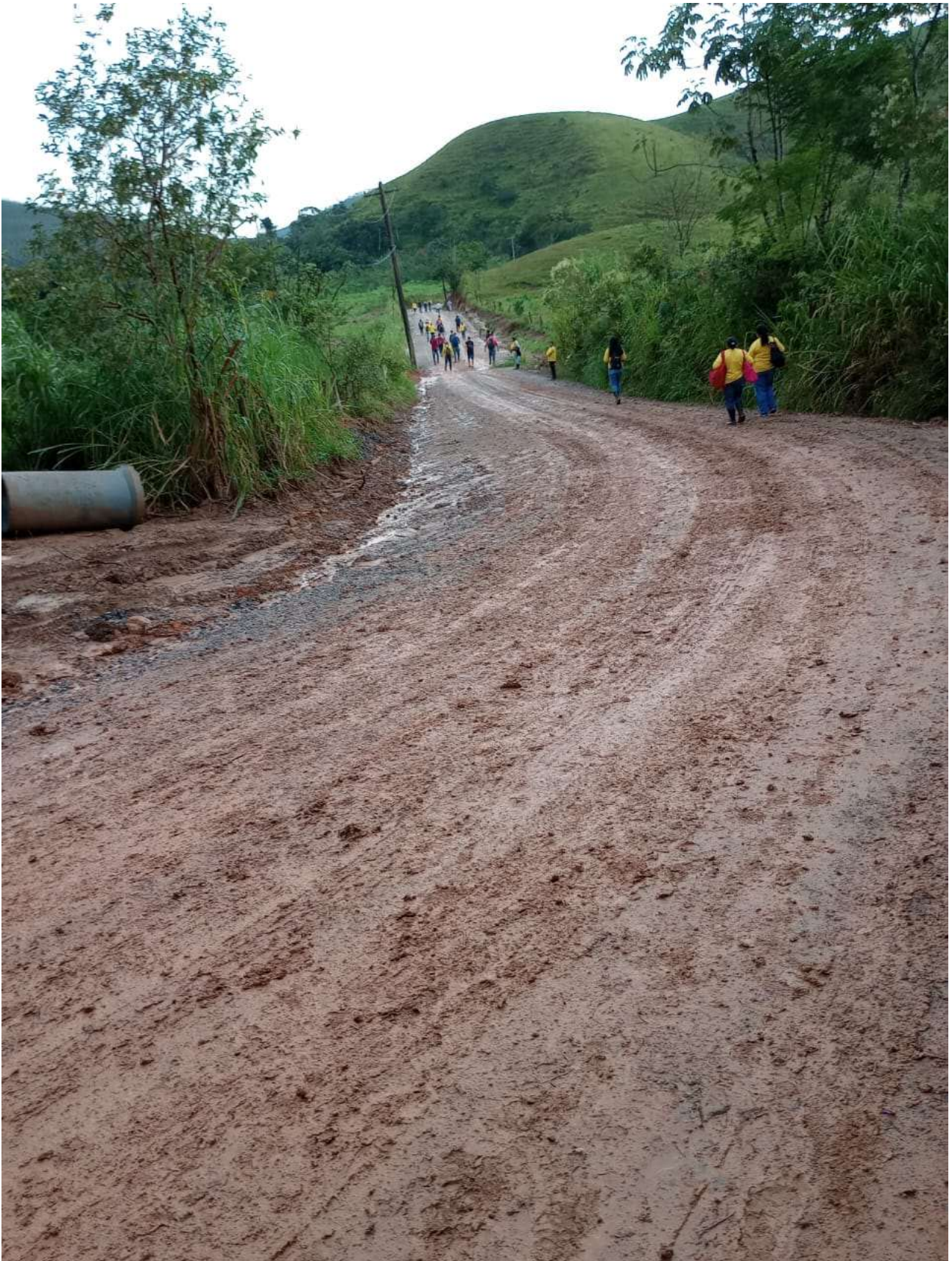
Estrada Municipal Emídio de Assis Alves Neto – colaboradores de empresa, se deslocando a pé, haja vista que o lamaçal formado na estrada, impediu o tráfego de veículos.
