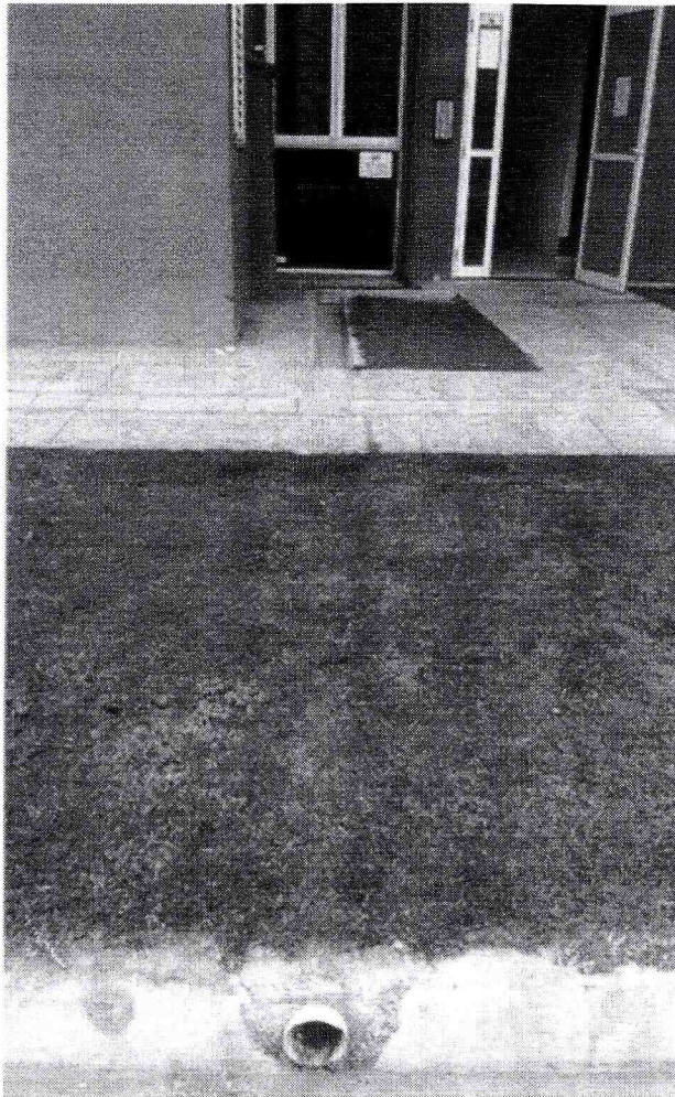
Canaletas de drenagem executada nas entradas
