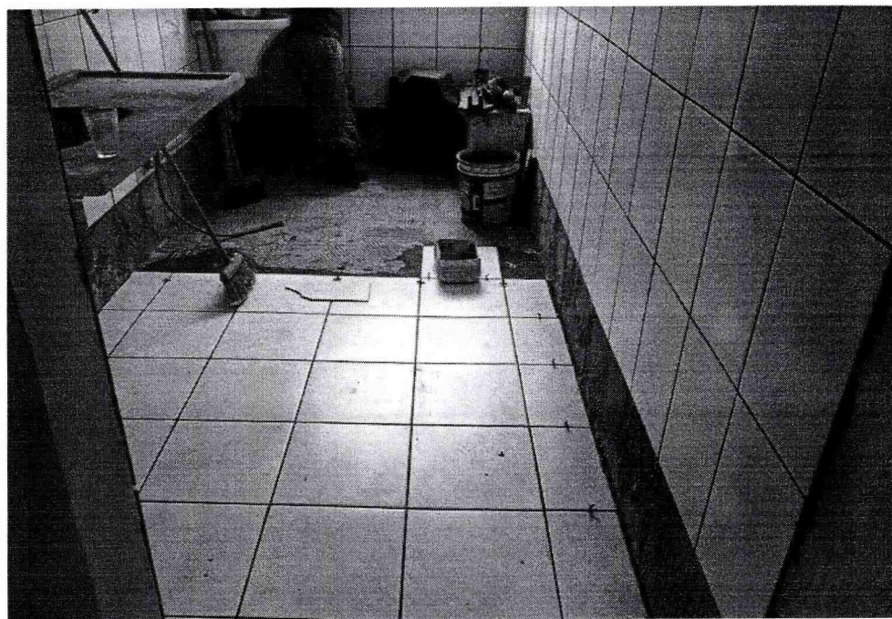
Execução de manutenção de piso e azulejo nas cozinhas
