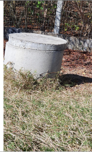
FOTO 08 – Vista da área com a localização do PV 09- Drenagem conforme Planta de Drenagem
