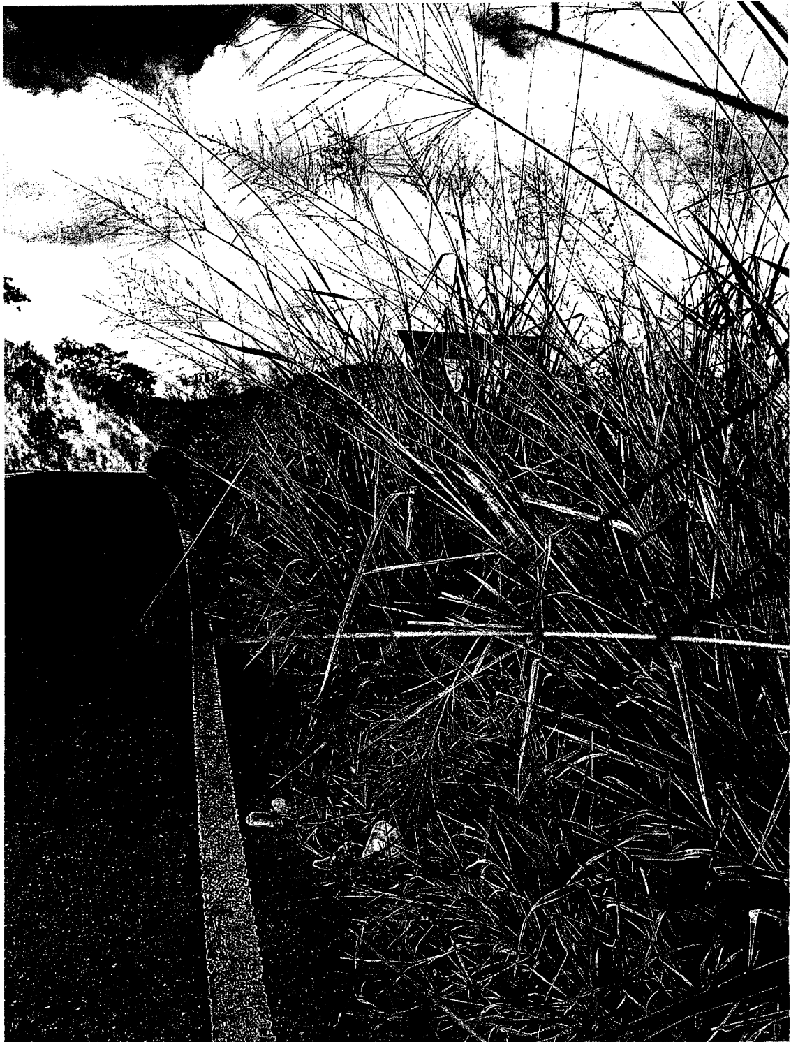
Margens da Rodovia SP62 – Trevo de saída de APARECIDA, sentido Pindamonhangaba, matagal esta obstruindo a placa de sinalização.
