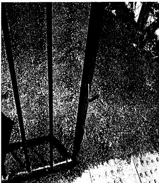
Gradil enferrujado e amarrado com fio de nylon com risco de cair e causar acidentes
