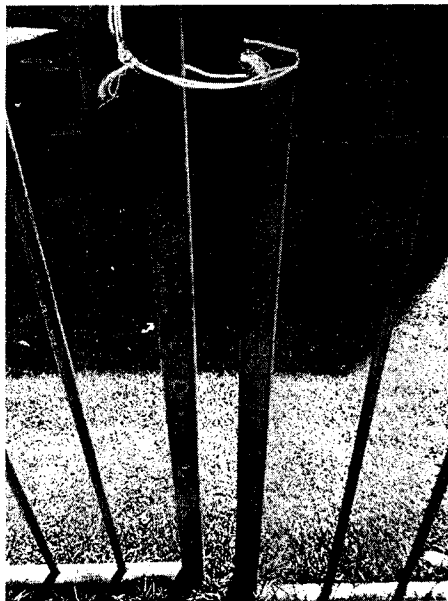
Gradil enferrujado e amarrado com fio de nylon com risco de cair e causar acidentes
