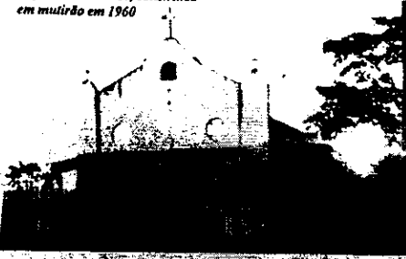
Capela de São José, construída em mutirão em 1960
