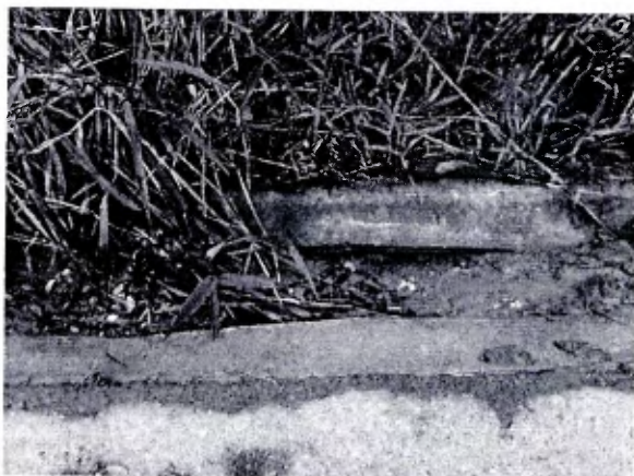
2- Todas as bocas de lobo estão obstruídas por mato e terra
