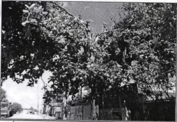
Árvore localizada na frente da escola. Seus galhos estão passando sobre a rede elétrica da rua e da escola.
