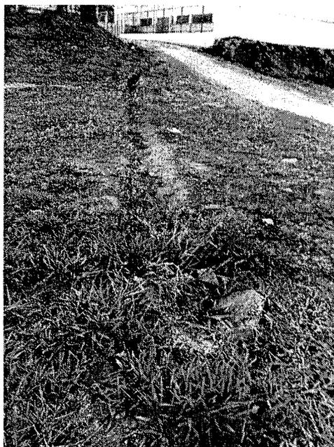
**2- Tampa da caixa coletora de águas pluviais – encontra-se quebrada.**
