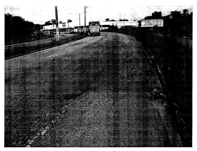
Anel Viário – após túnel (próximo ao Tenda), parte do asfalto encontra-se com elevação, com risco de ser um causador de acidentes. 15 de maio de 2017.
