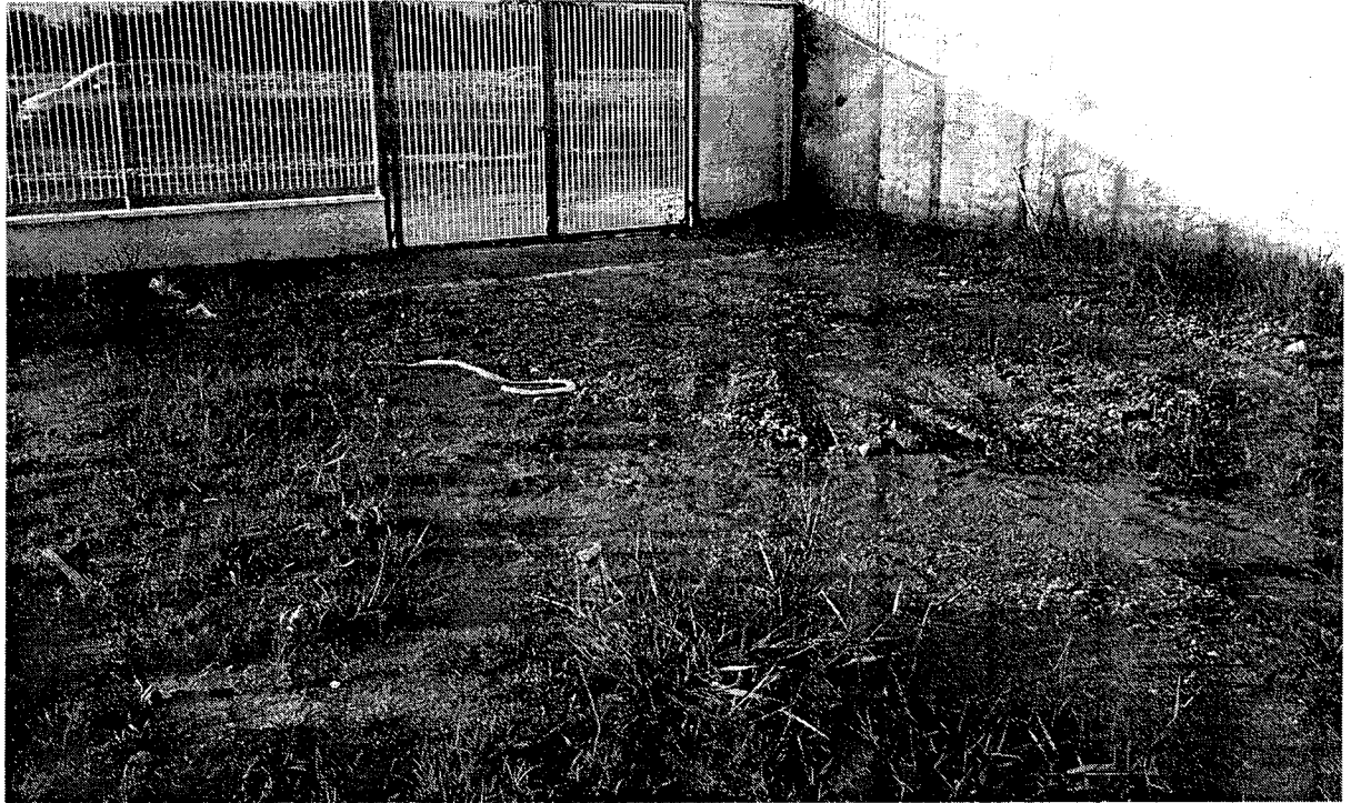
Calçamento entrada dos veículos
