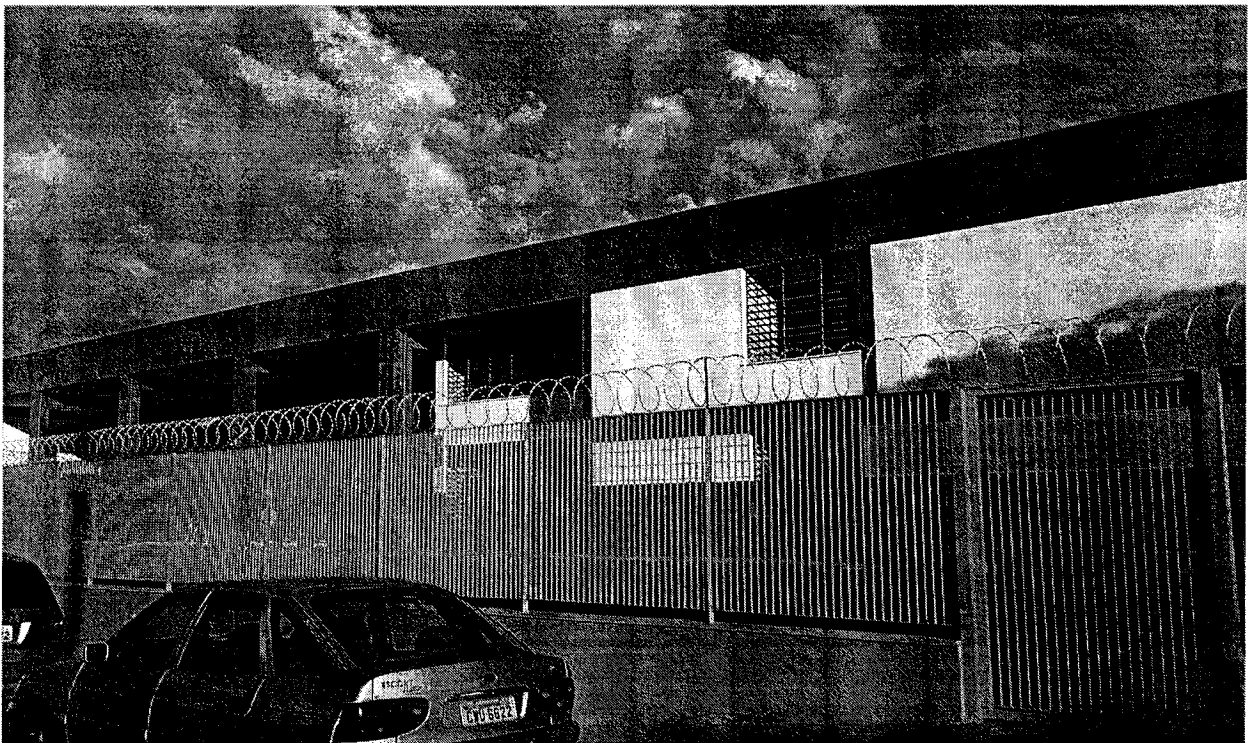
Instalação de toldo no portão de acesso dos alunos
