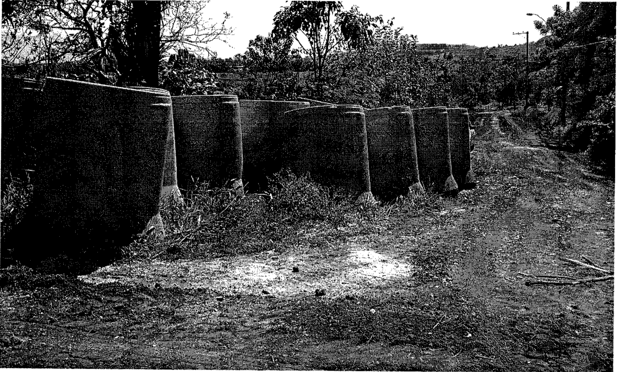
Tubulação depositada na rua das Laranjeiras
