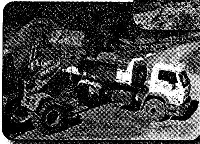
Pá Carregadeira - Solo e Brita sendo preparado
