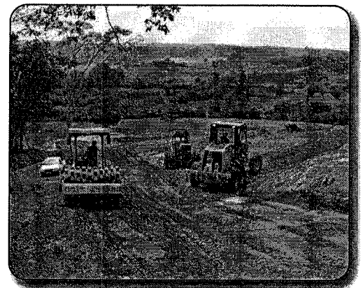
Abertura das Estruturas
