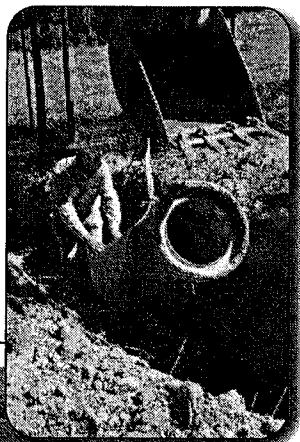
Assentamento de bueiros tubulares de fluxo transversal
