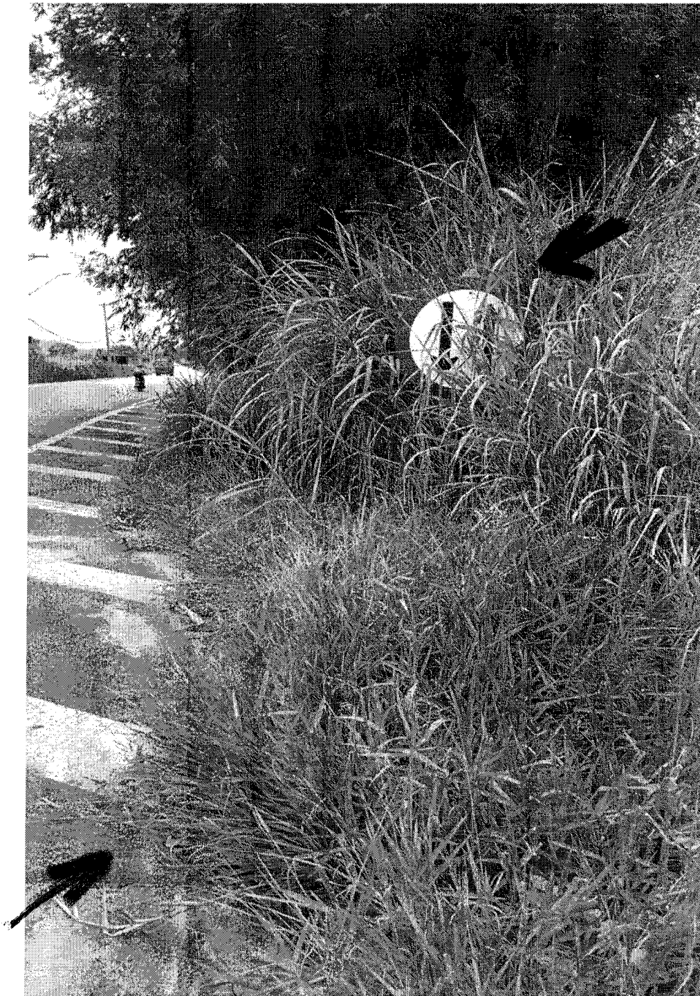
Mato invadindo faixa do acostamento e tapando a placa de sinalização, foto de 9 de abril de 2016
