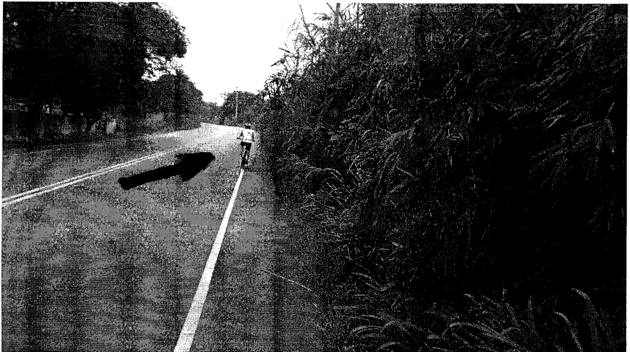
Ciclista andando próximo ao leito carroçável para desviar do mato alto que invadiu o acostamento – foto tirada em 09 de abril de 2016
