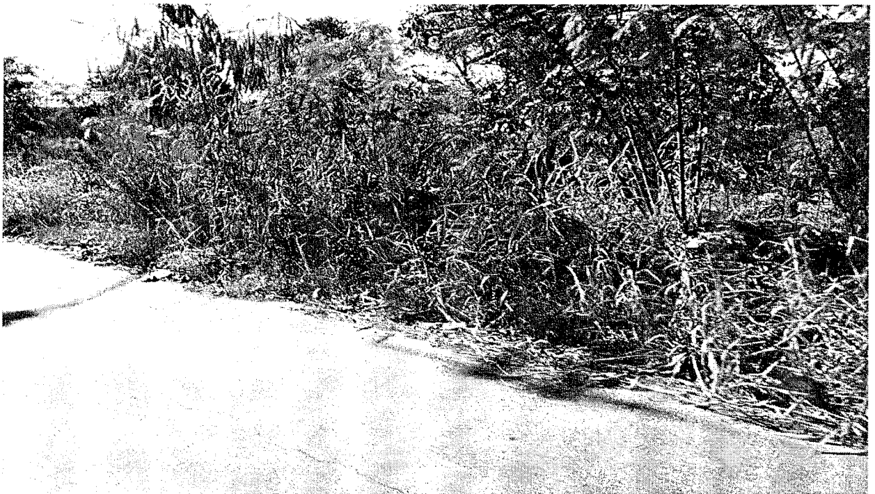
Margens da Estrada, tomada por mato
