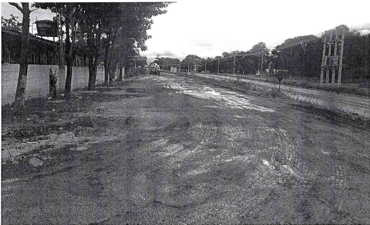
Rua das Andorinhas, frente a empresa de concreto
