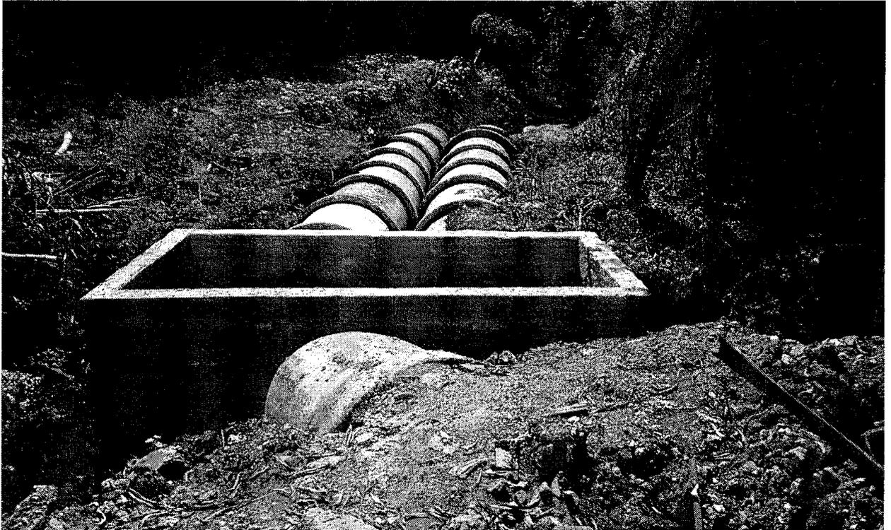
**Ao lado da caixa de passagem (foto) existe uma mina d'água, que precisa fazer o dreno, antes de fazer o aterro.**
