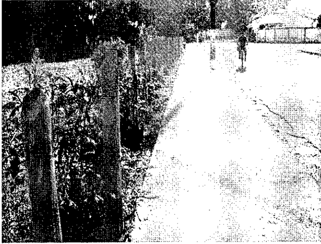
MOURÕES DESALINHADOS EM RELAÇÃO A CALÇADA
