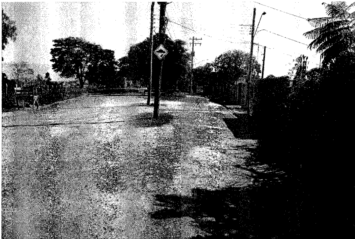
Postes localizados no meio da Rua Benedito Mário dos Santos, Bairro das Campinas
