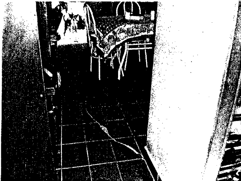
Foto 02 – Piso da cozinha afundando.
