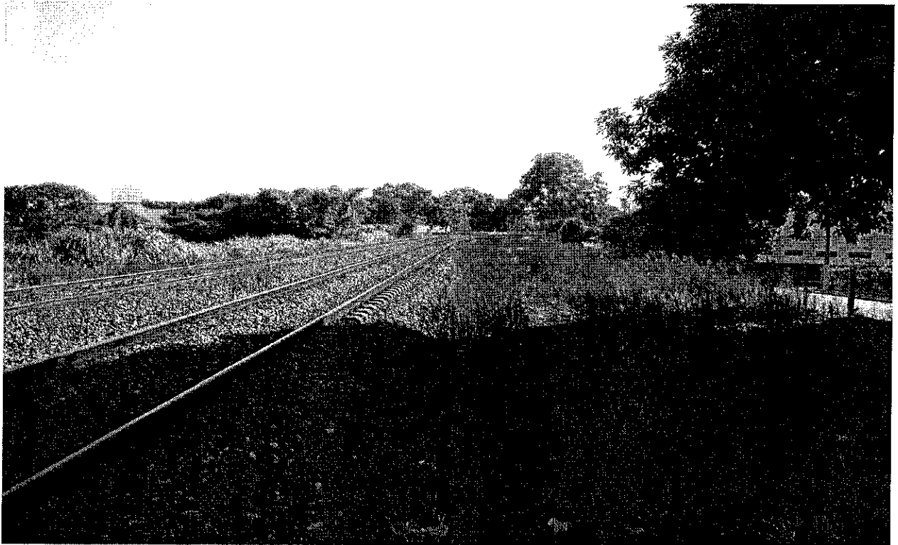
LINHA FÉRREA – LOCAL PRÓXIMO À ASSOCIAÇÃO ATLÉTICA FERROVIÁRIA – PINDAMONHANGABA-SP (SENTIDO RIO) – PARALELA A RUA ALVARO PINTO MADUREIRA – 29/01/2014
