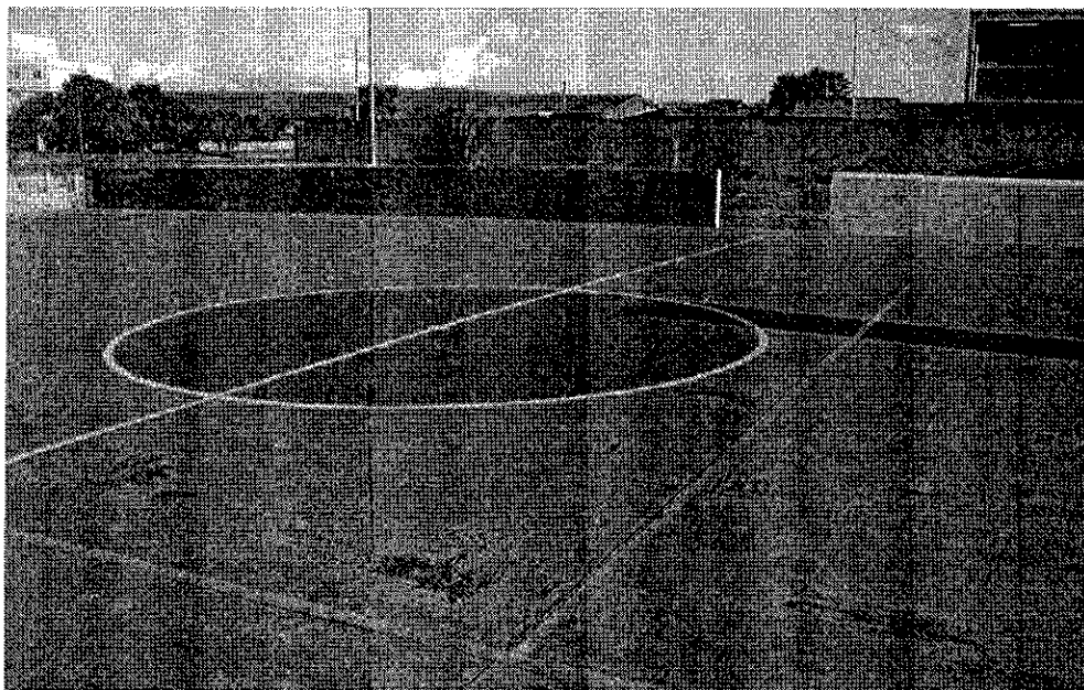
- VISTA DA QUADRA – PINTURA PARCIAL DO PISO E MURETA
