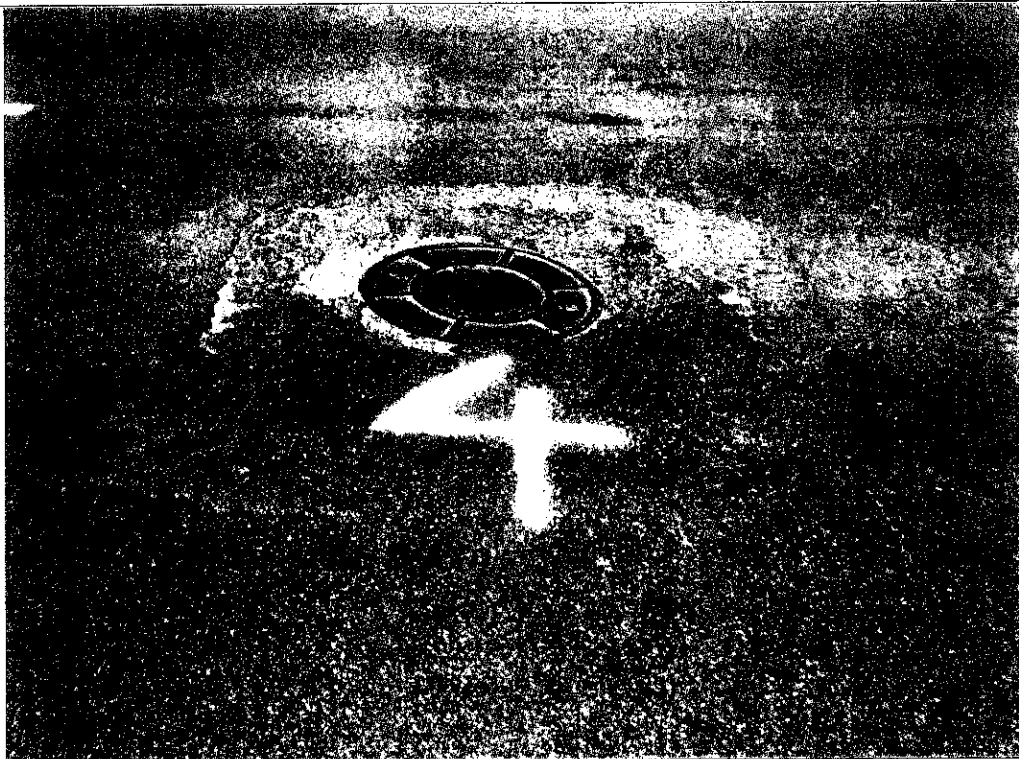
Reparo 4 – Basta observar.
