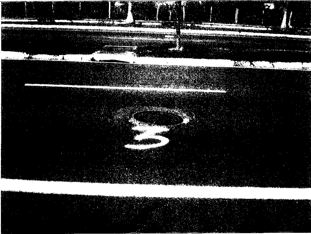
Reparo 3 – Conjunto PV afundado no piso. Sem anel de concreto em torno do PV.
