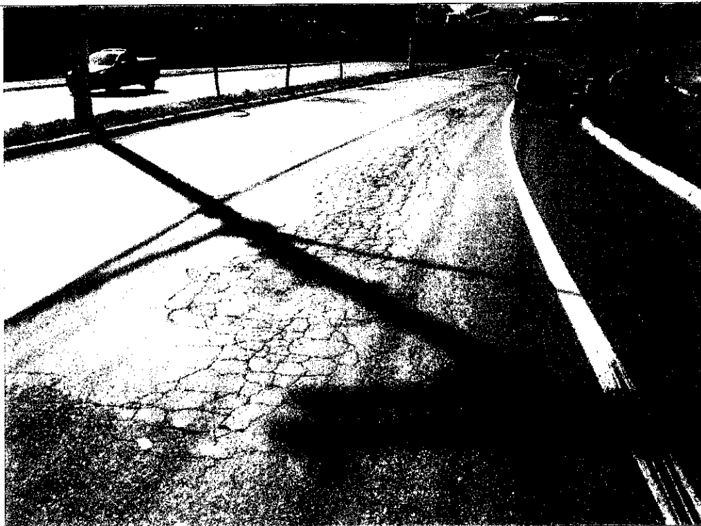
Longo trecho afundando, rachando e prestes a soltar partes. Provável rede subterrânea.
