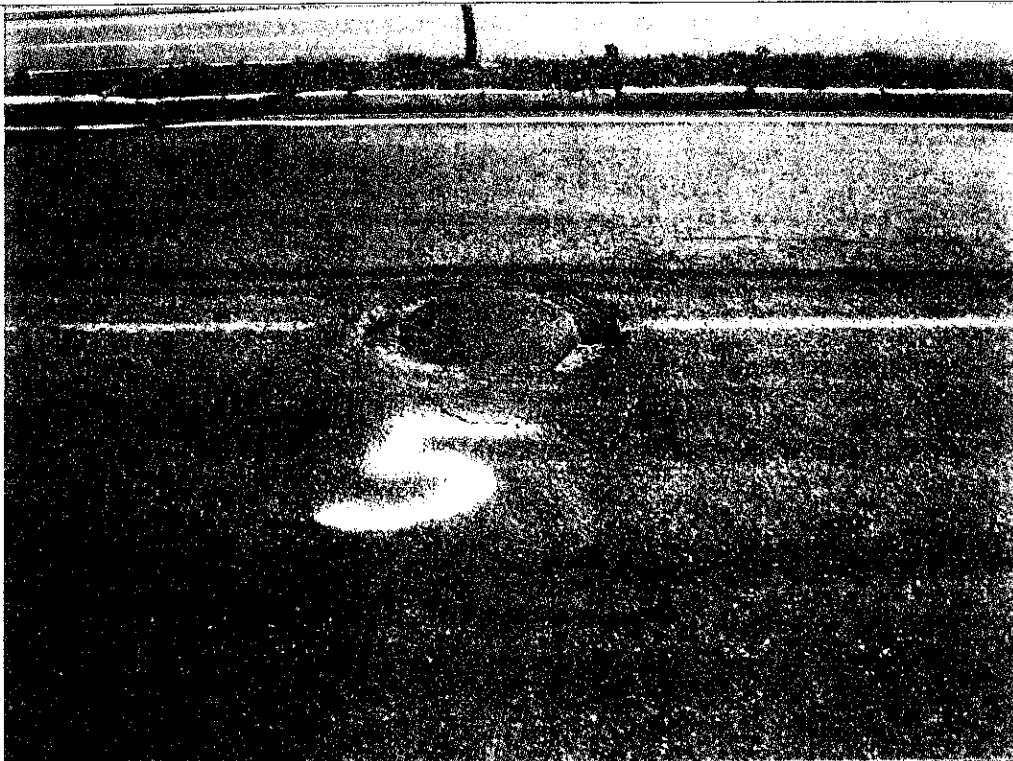
Reparo 5 – Serviço mal feito. PV coberto com asfalto. Asfalto se soltando.
