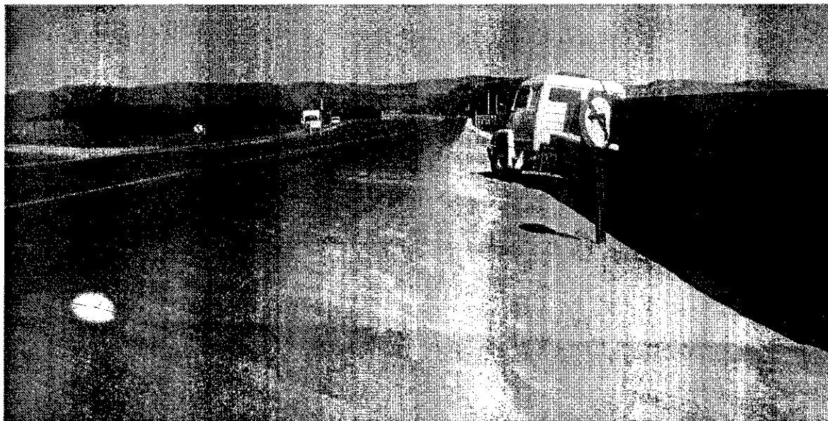
FOTO 1 - CAMINHÃO NO ACOSTAMENTO, AGUARDANDO PARA DAR INÍCIO A TRAVESSIA PARA O OUTRO LADO DA RODOVIA
