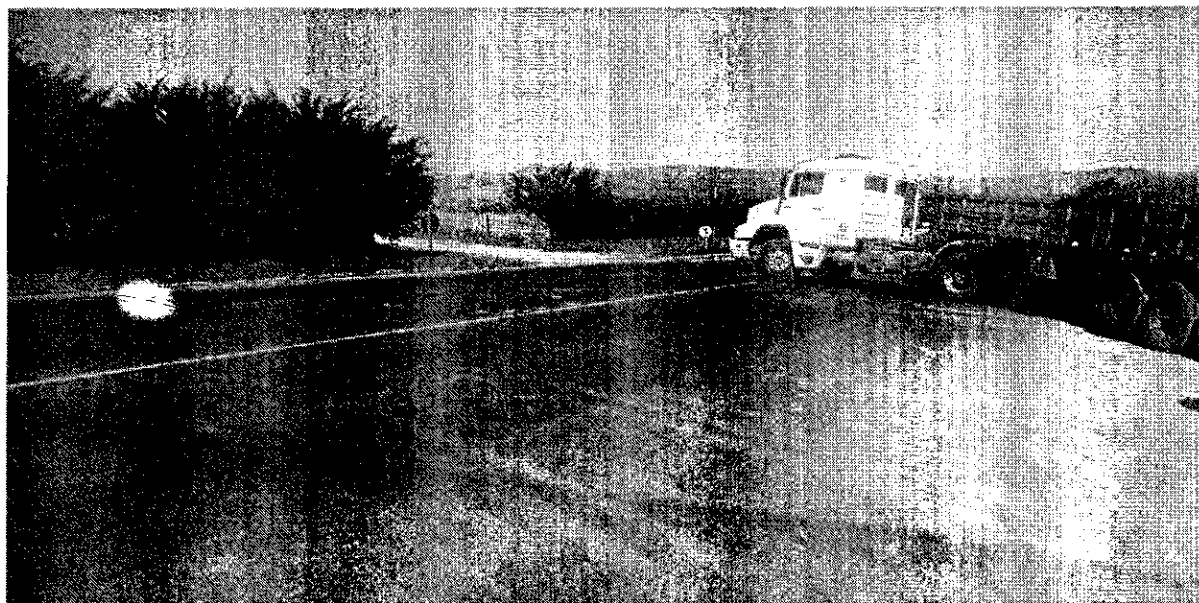
FOTO 2 - CAMINHÃO FAZENDO MANOBRA ARRISCADA E PROIBIDA, POR FALTA DA ALÇA DE ACESSO.
