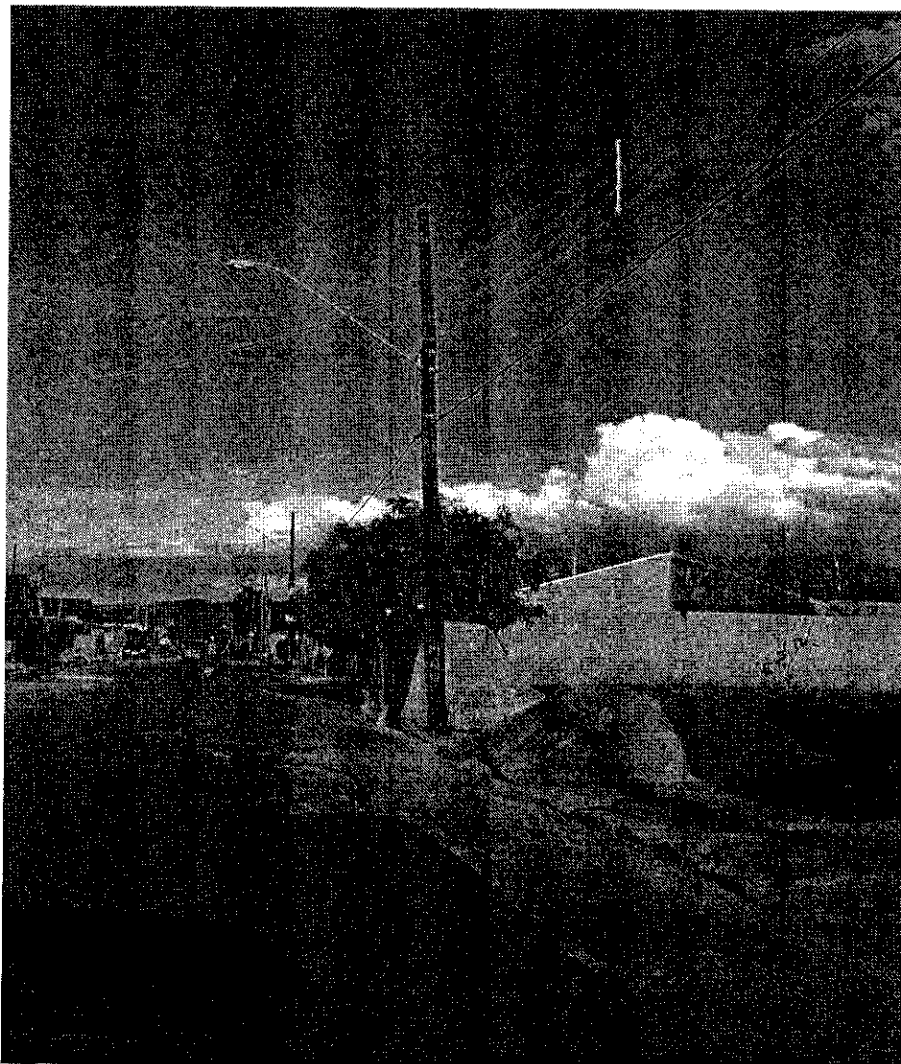
Rua Soldado Paulo Alves – Residencial Vista Alegre - Feital Detalhe: Poste de Madeira
