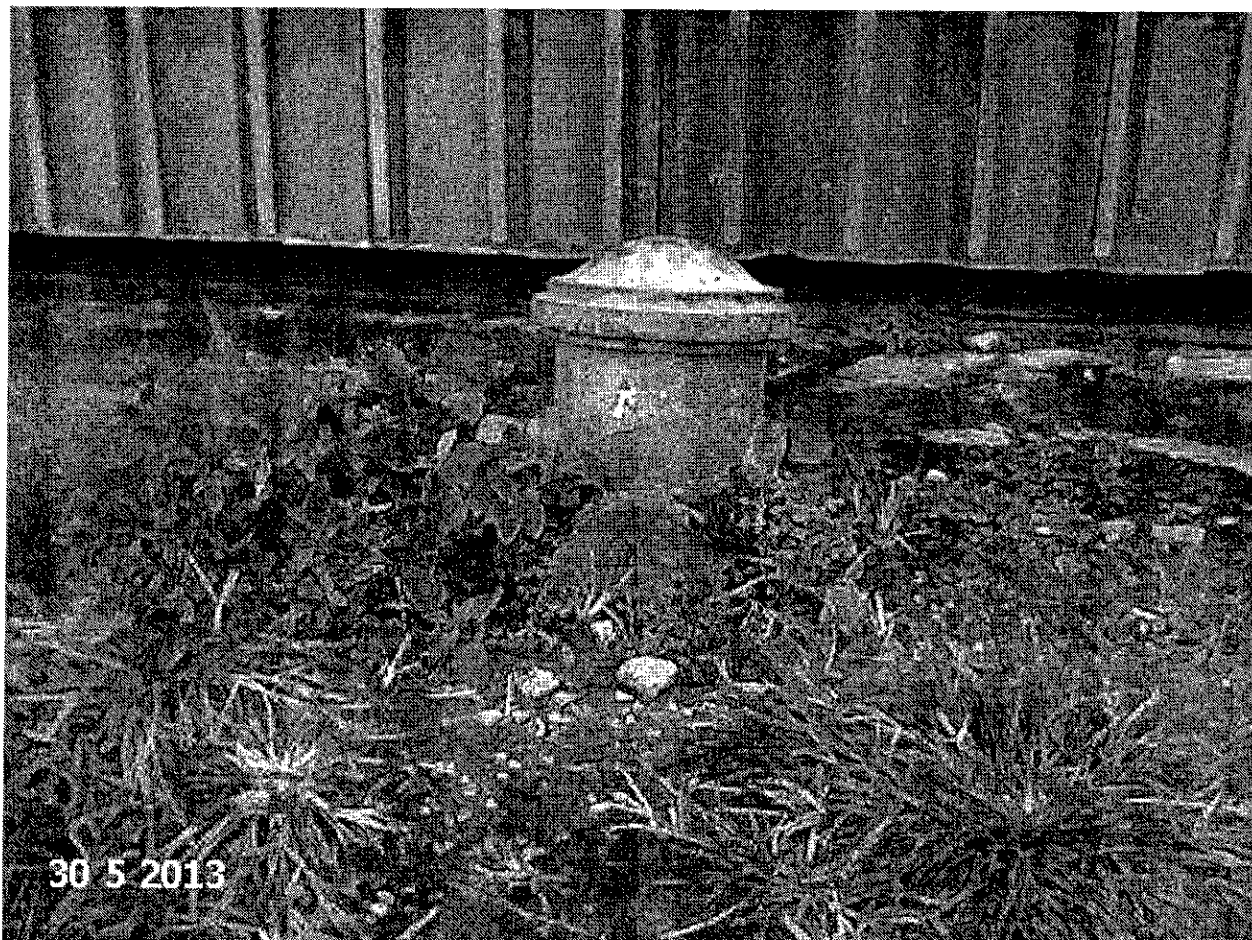
HIDRANTE LOCALIZADO NA RUA GEORG HELDUSCHKA - CARANGOLA
