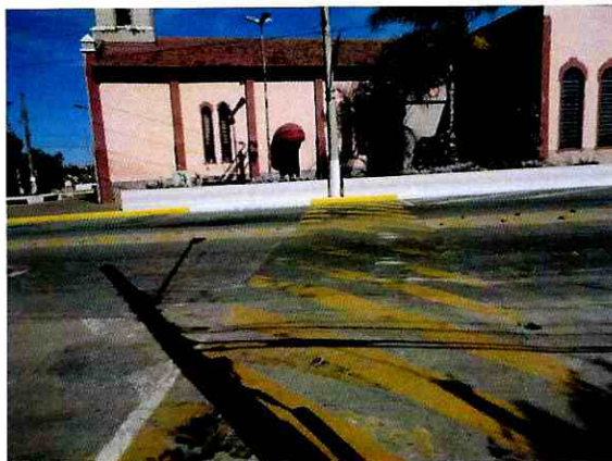
Lombada já existente, em frente ao Recinto
