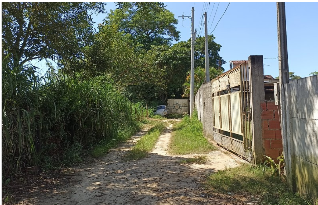
Foto 14: Trecho final da Travessa está sendo tomado pelo mato, por falta de manutenção.
