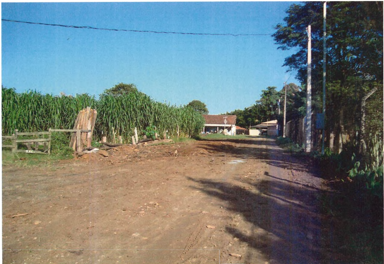
Foto 04: Trecho da Rua, onde foram retirados troncos de árvores que obstruíam parte da via.
