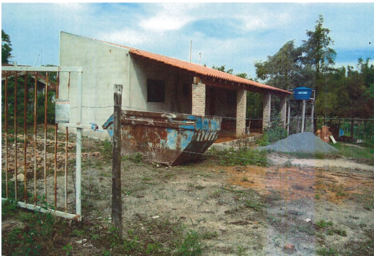
Foto 08: Outra casa existente no local.
