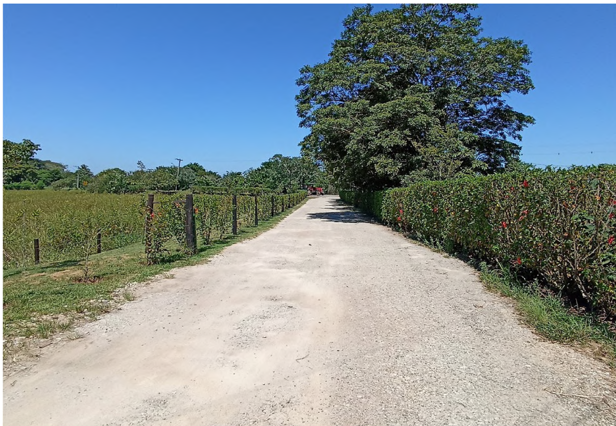
Foto 03: Trecho inicial da Travessa.
