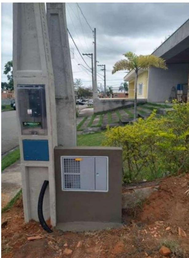
2- Poste Padrão EDP – com medidor de leitura de consumo de energia, com cx de disjuntores – lado externo (Segundo informações este novo modelo c/ a caixa de disjuntores do lado externo da casa, pode acarretar INSEGURANÇA, pois os disjuntores podem ser facilmente desligados.
