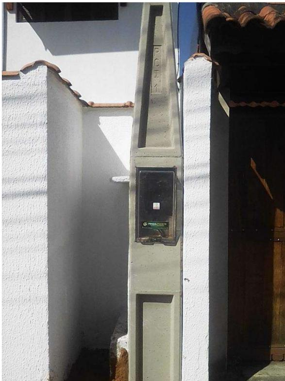
1- Poste Padrão EDP – com medidor de leitura de consumo de energia – lado externo (modelo que estava sendo utilizado até início de 2023) Somente o leitor fica do lado externo.
