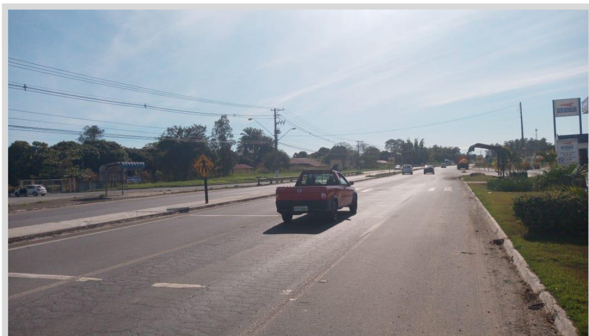
Foto 02 – Km 154,200m – Sentido Leste e Oeste.
