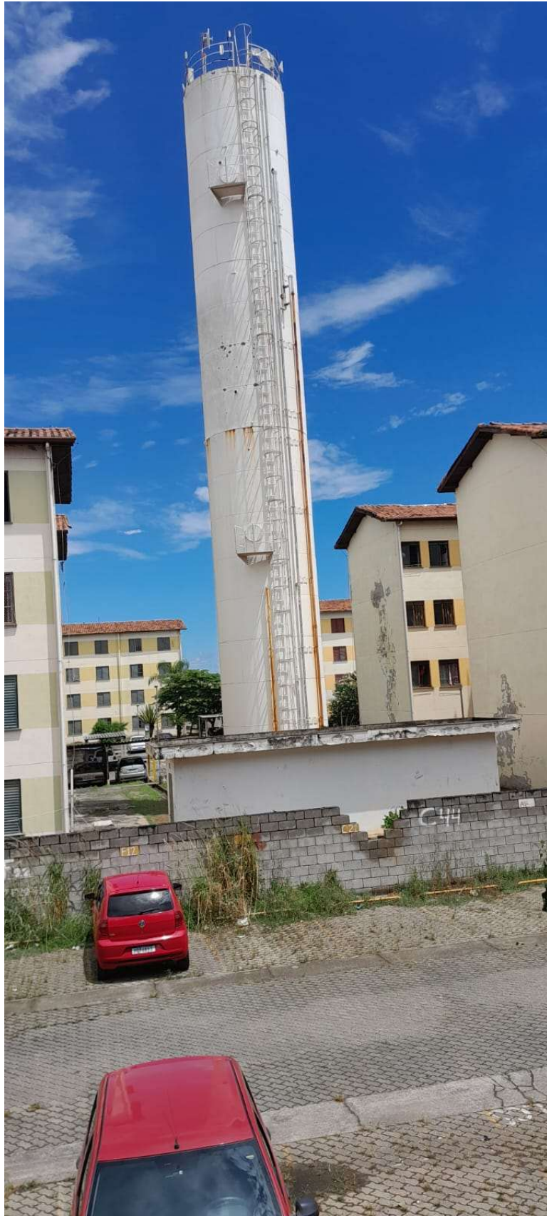
Caixa d'água – CDHU – bairro Azeredo – Moreira César - Pindamonhangaba/SP
